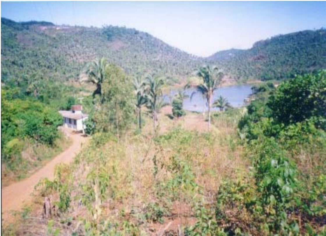
FOTO 20 - Açude Frecheira (Meruoca) c/ estação de bombeamento flutuante
