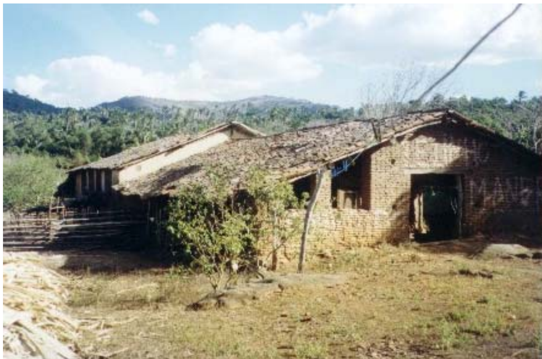
FOTO 13 – Casa de engenho que encontra-se localizada na área da bacia hidráulica do futuro reservatório.
