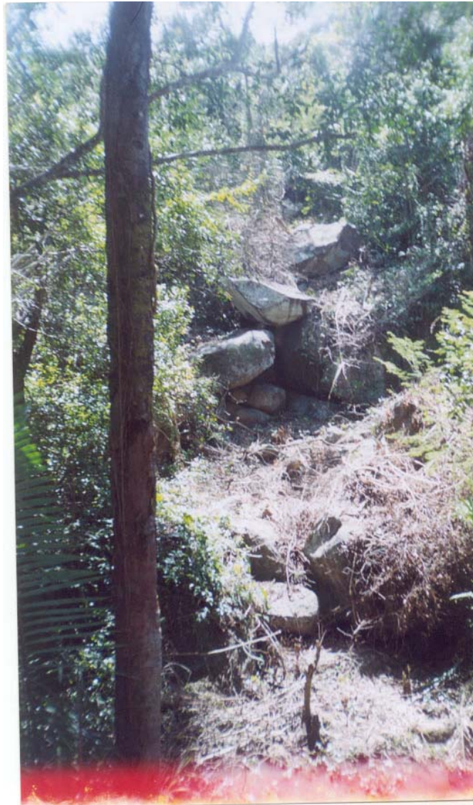
FOTO 01 – Detalhe da ombreira esquerda, onde observa-se a presença de afloramentos rochosos e de um grande volume de blocos de rochas soltos.
